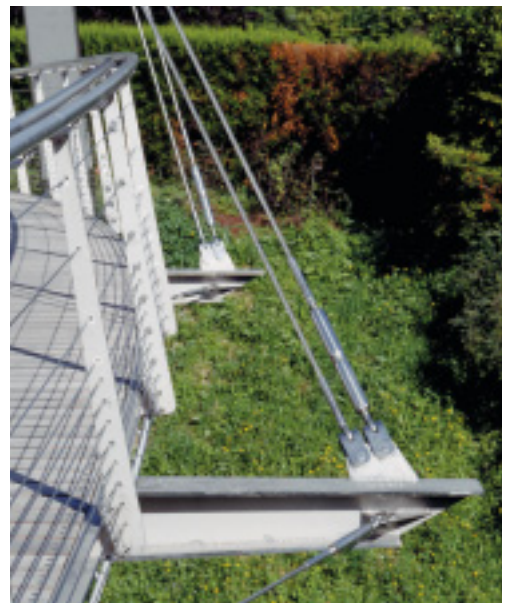
Paarweise angeordnete Zugstangen verbinden die Querträger mit dem Bogen.
