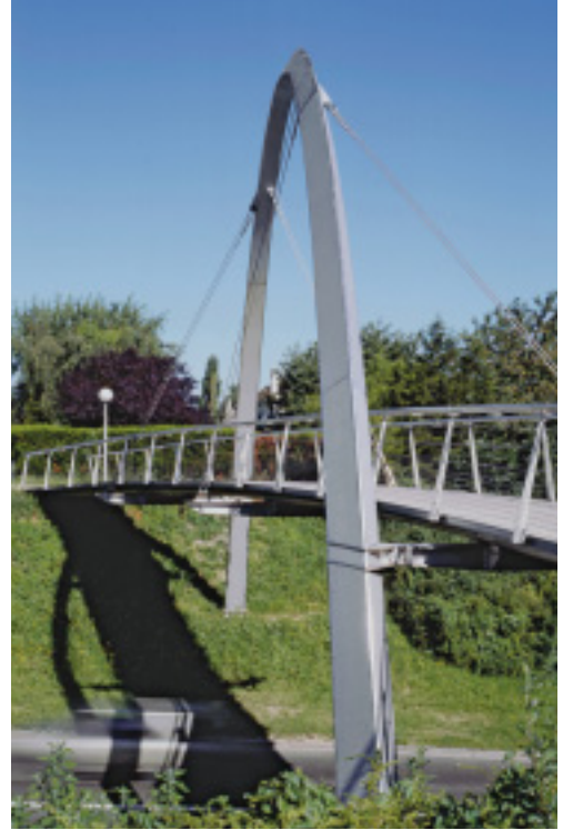
Der dreieckige Querschnitt des Bogens verjüngt sich vom Fundament zum Scheitelpunkt.
